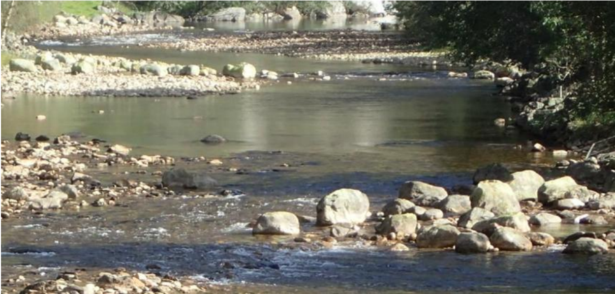
Figur 2.11 Eksempel på buneformete steinutlegg i Frafjordelva, som bidrar til variasjon i en tidligere homogen del av elva. Bildet er hentet fra Pulg et. al, 2018.
